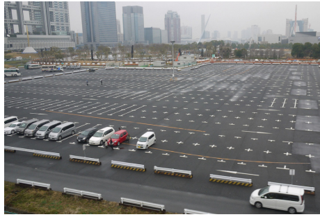
Contrôler l'accès aux parkings
