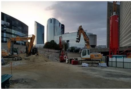
Protéger les sites en construction
