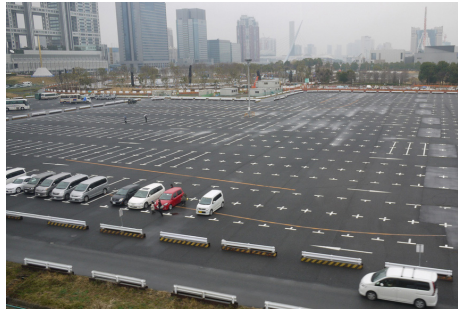
Contrôler l'accès aux parkings
