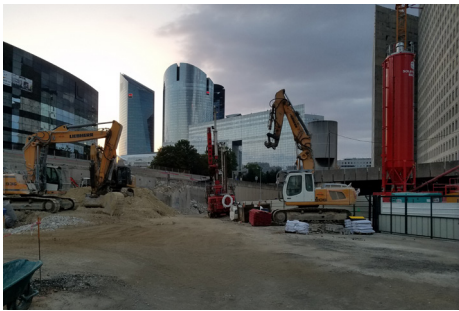
Protéger les sites en construction
